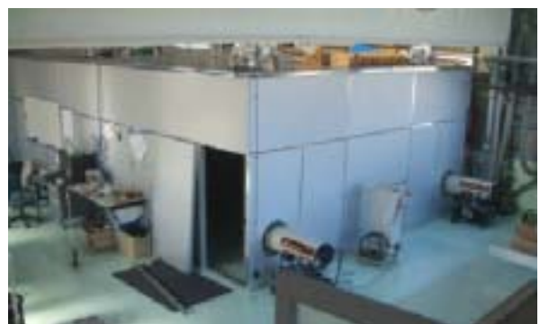
図 - 4 積層 / 硬化室の概観
